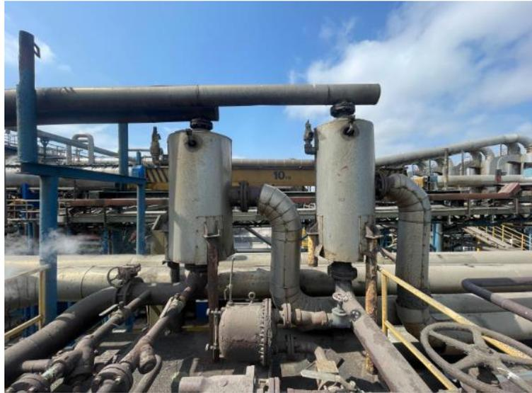
Figura 6: Conexión de entrada y salida de tanque flash
