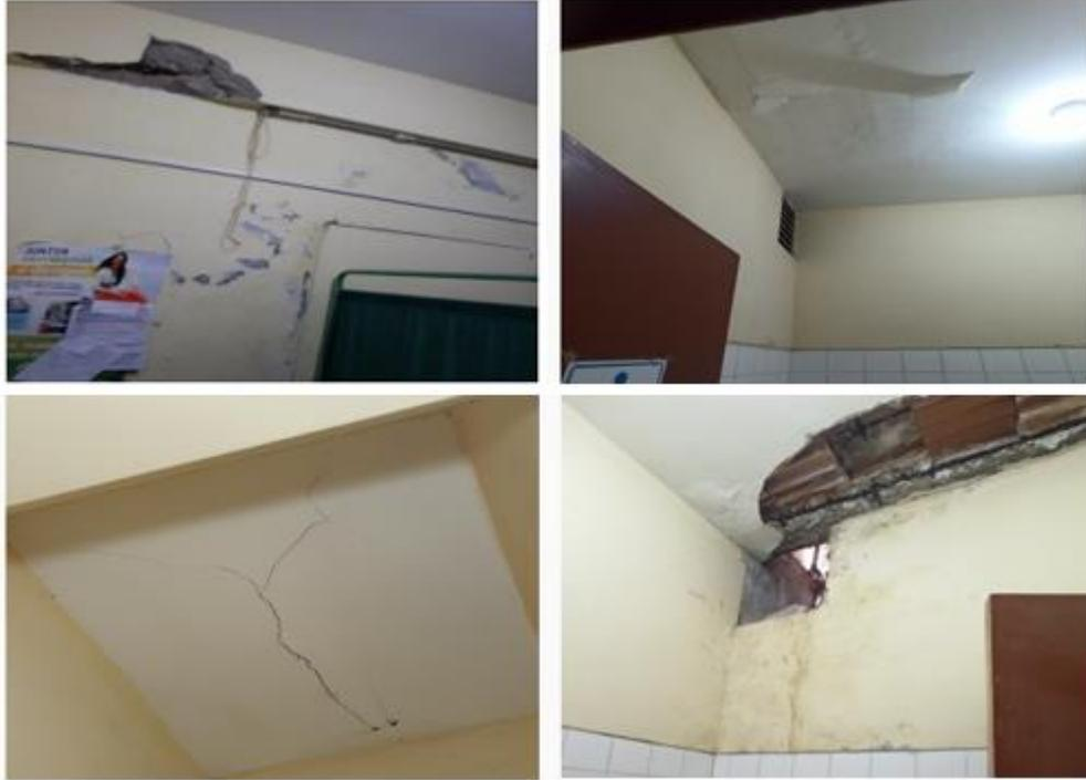
*Foto N° 05:* Presencia de fisuras en techos, así mismo, desprendimiento del recubrimiento y exposición del acero tanto en vigas como en viguetas los cuales se encuentran totalmente oxidados
