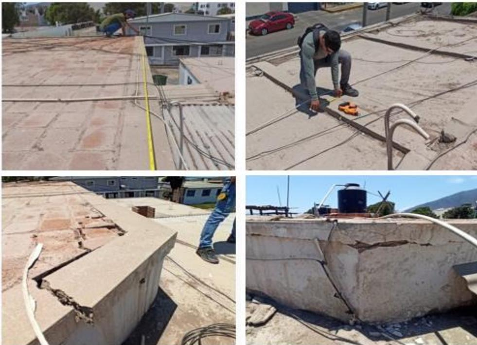
*Foto N° 06:* Medición perimetral del techo y elementos estructurales del departamento de Emergencia, así mismo, se observa el mal estado en el que se encuentra el techo
