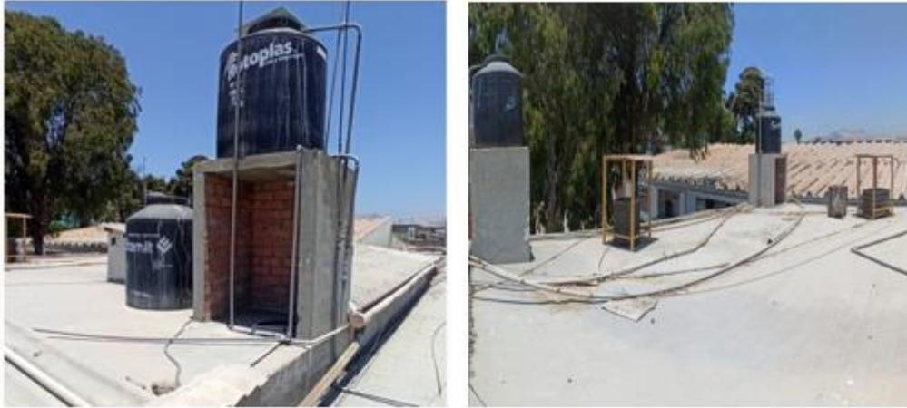
*Foto N° 11:* Sobrecarga de pesos puntuales excéntricos sobre el techo del 1er piso, esto genera efectos de torsión en la estructura.
