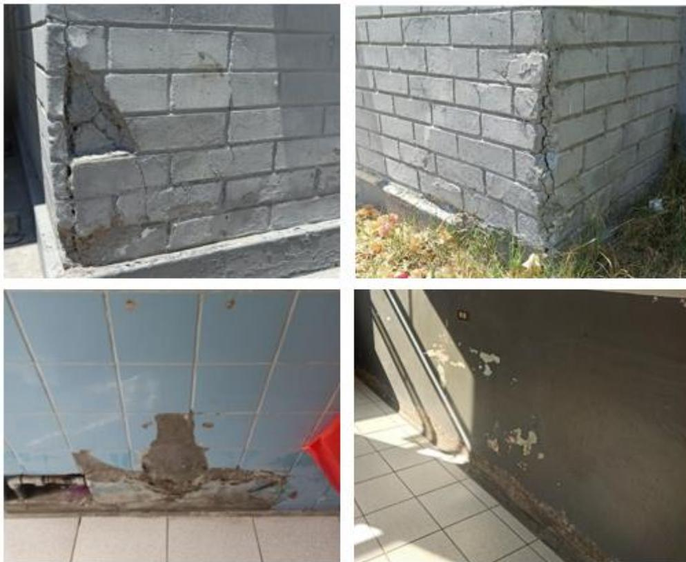
*Foto N° 15:* Se aprecia el ambiente de Cirugía totalmente afectado por el salitre
