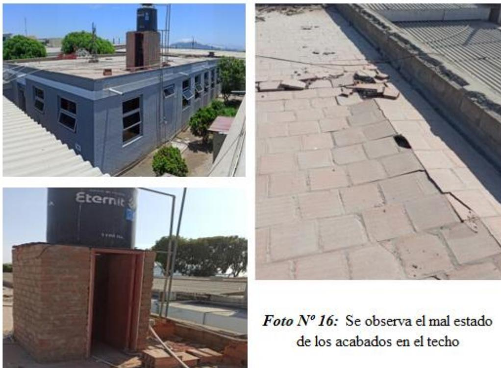
*Foto N° 16:* Se observa el mal estado de los acabados en el techo
