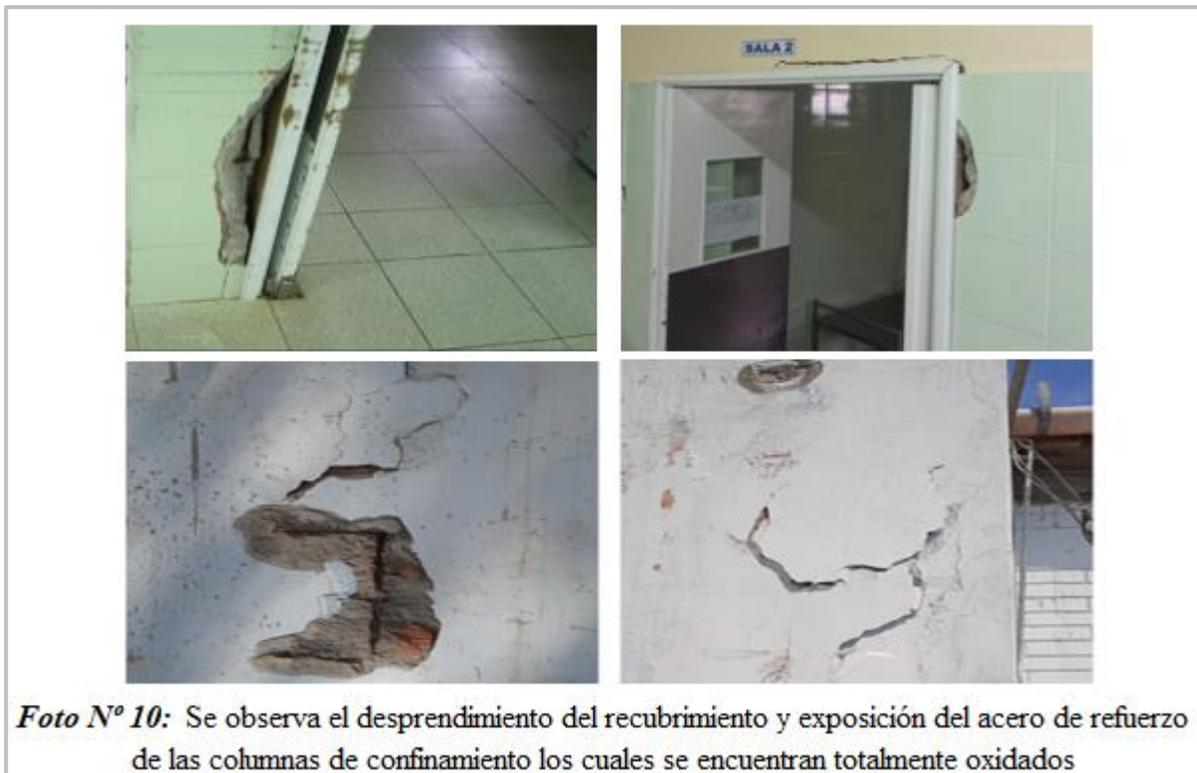
Foto N° 10: Se observa el desprendimiento del recubrimiento y exposición del acero de refuerzo de las columnas de confinamiento los cuales se encuentran totalmente oxidados
