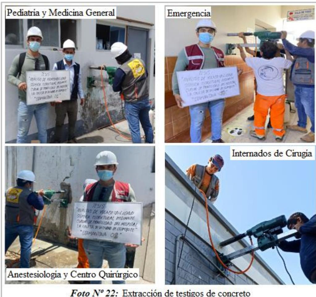
Foto N° 22: Extracción de testigos de concreto
