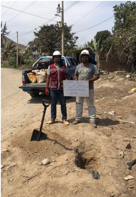
Fotografía N°01.- Excavación de calicata 1 y 2.
