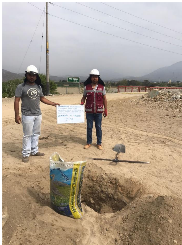
Fotografía N°04.- Excavación de calicata 8.
