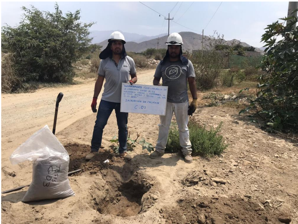
Fotografía N°02.- Excavación de calicata 3.
