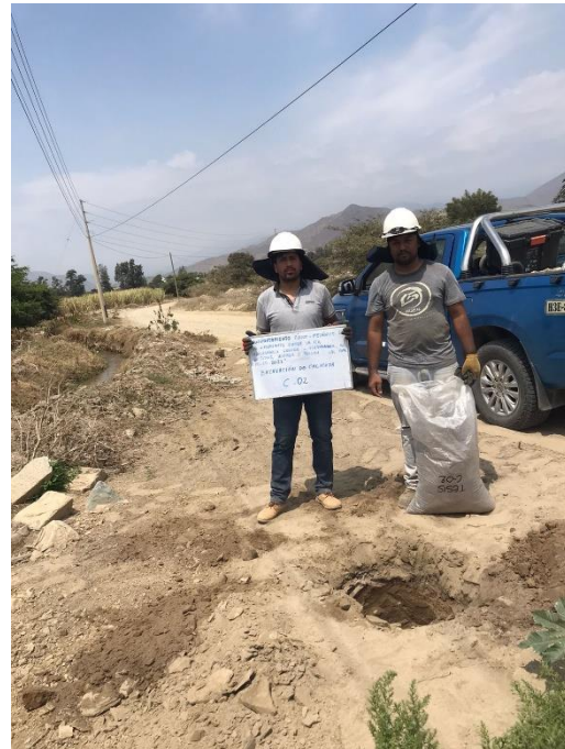
Fotografía N°01.- Excavación de calicata 1 y 2.
