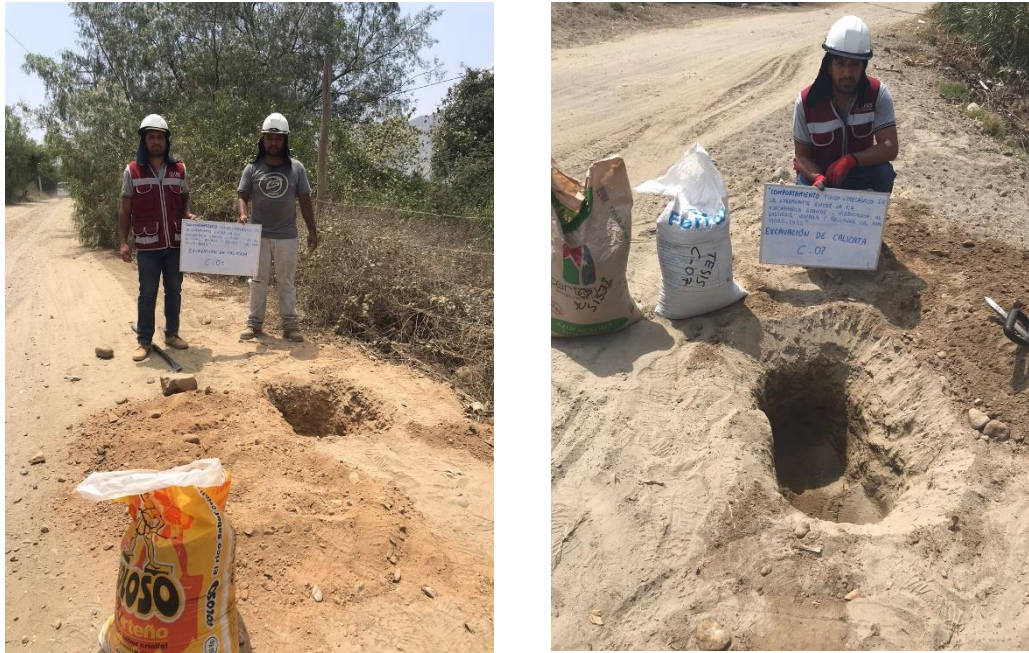
Fotografía N°03.- Excavación de calicata 4 y 7.
