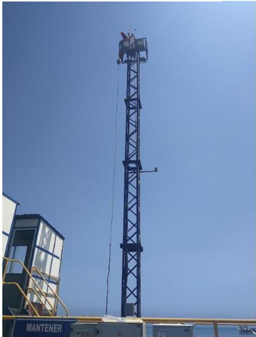
Ilustración 45: Instalación de anemómetro en Cerro Austral
