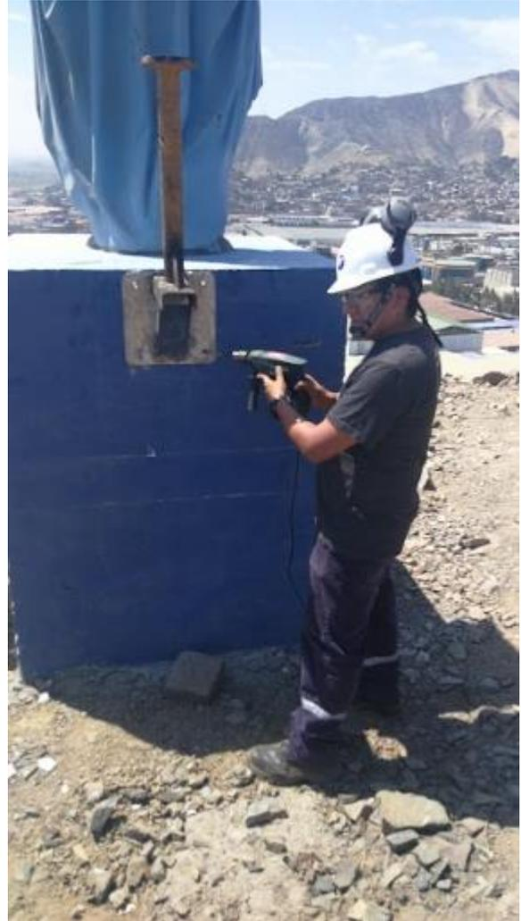
Ilustración 46: Instalación de anemómetro en Virgen Austral
