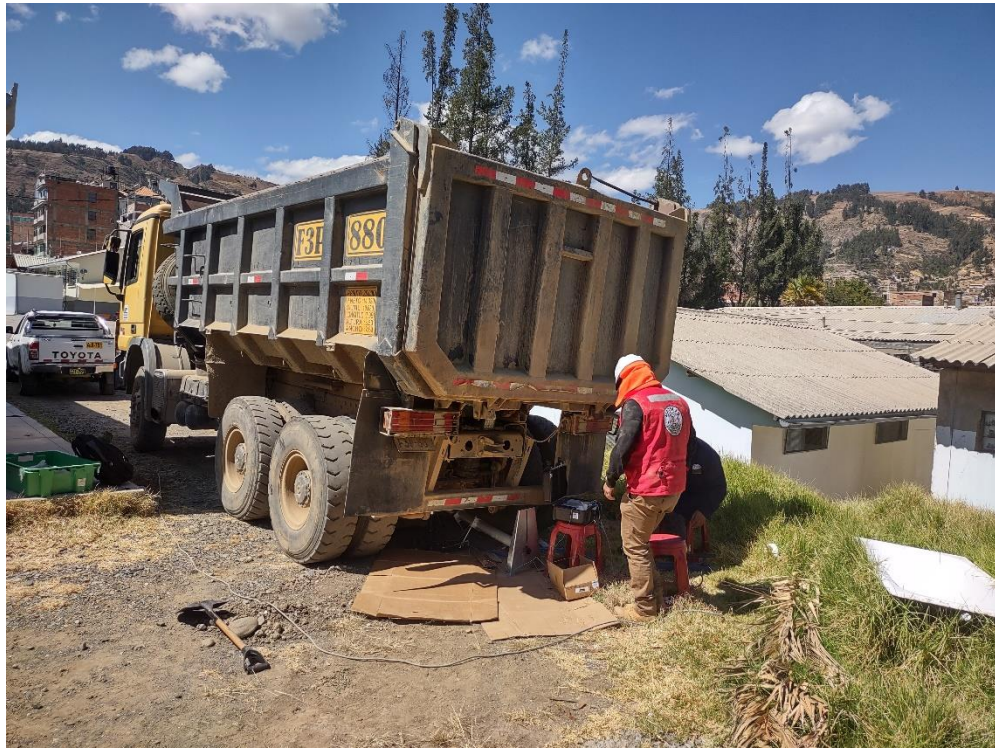
Fotografía 3: Se puede ver el ensayo de placa de carga N° 02 (P-2) dentro del hospital Víctor Ramos Guardia.
