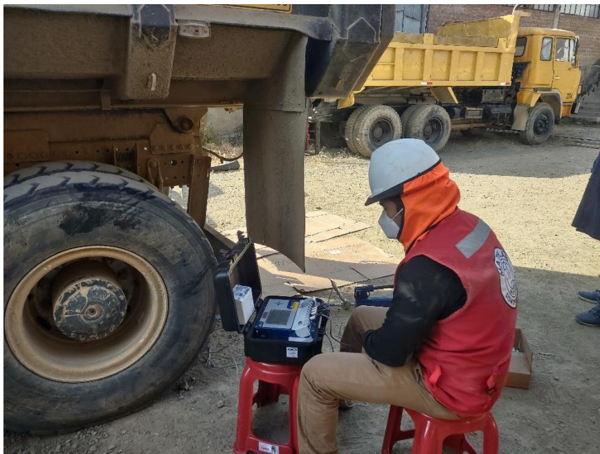
Fotografía 12: se puede ver la adquisición de datos en el ensayo de placa de carga N° 7 (P-7) en la zona II-B.
