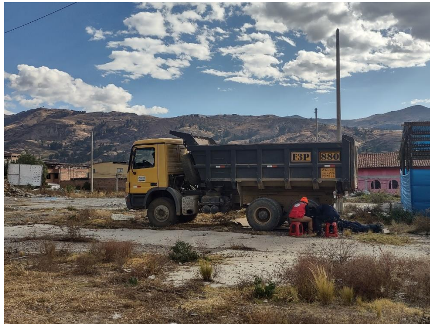
Fotografía 8: Se puede ver el equipo técnico realizando la el ensayo en la zona III-B.
