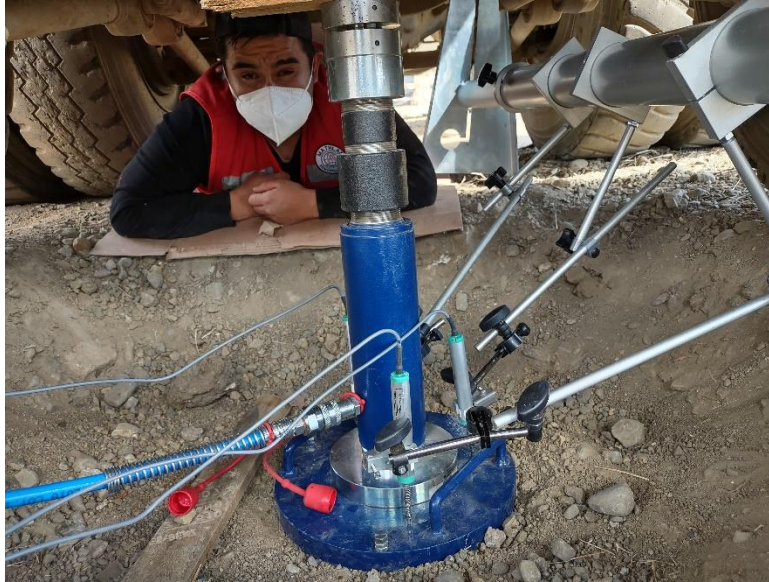
Fotografía 7 : Se puede ver la instalación de los deformímetros en el plato de carga para realizar el ensayo N° 05 (P-5).
