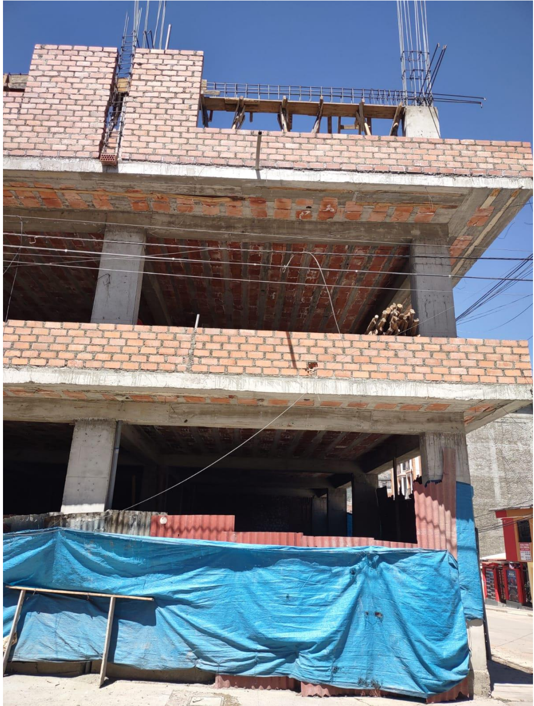
Fotografía 19: Se puede ver la vivienda en construcción a la fecha se encuentra en el tercer nivel, con proyección a 6 niveles, se ve los elementos estructurales usados.
