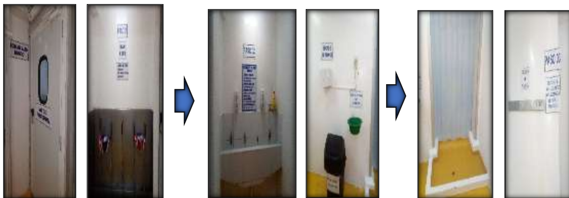
Figura 10. Zona de higienización (zona de alto riesgo), para lavado y revisado.
