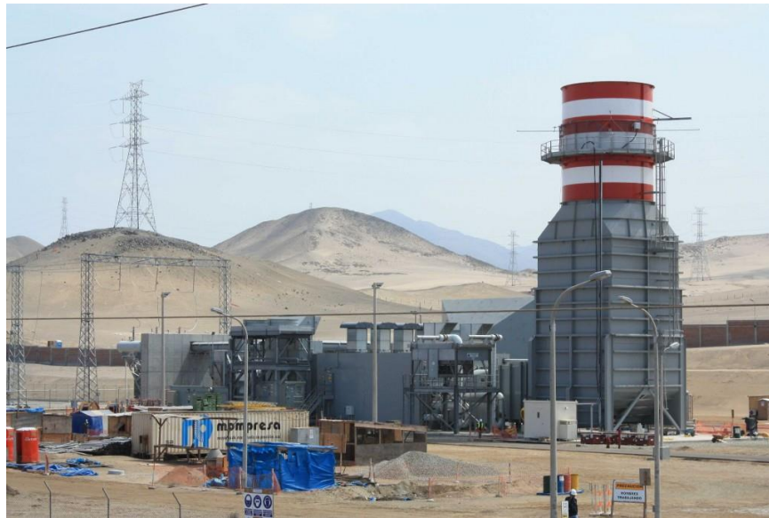
Figura 32 Vista lateral Central Termoeléctrica Las Flores Ciclo Simple
