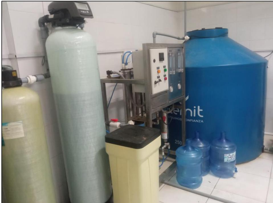
Foto n°04: Filtros, equipo de osmosis inversa y tanque de agua
