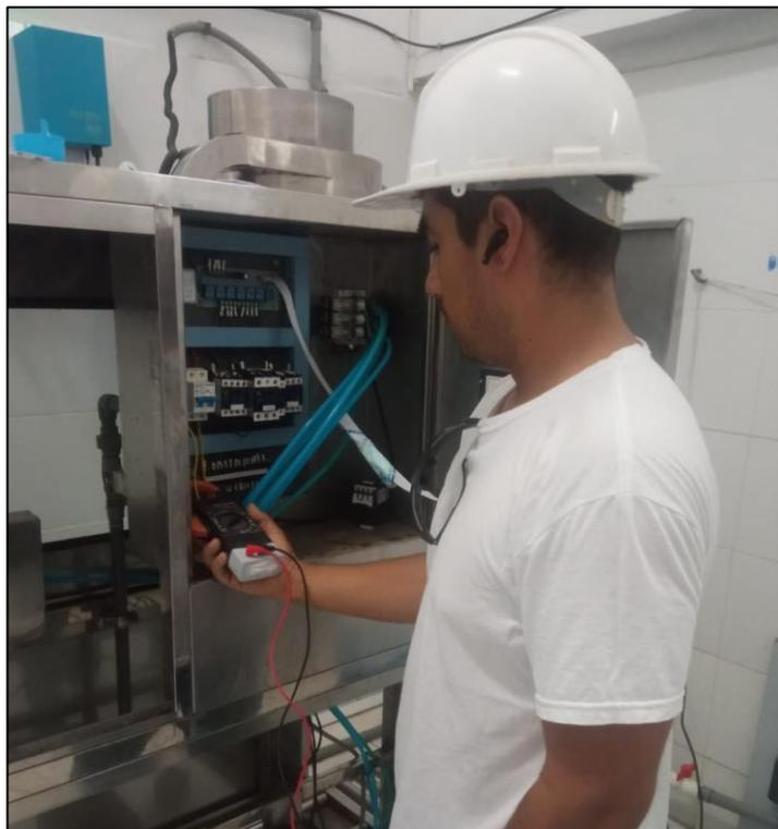
Foto n°05: Medición de corriente en tablero de osmosis inversa
