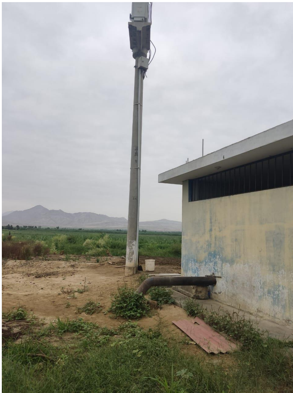
Fotografía 1: Vista de la caseta de Bombeo.
