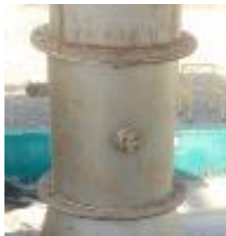
Figura 31: Dámper de 16'' de salida de vahos
