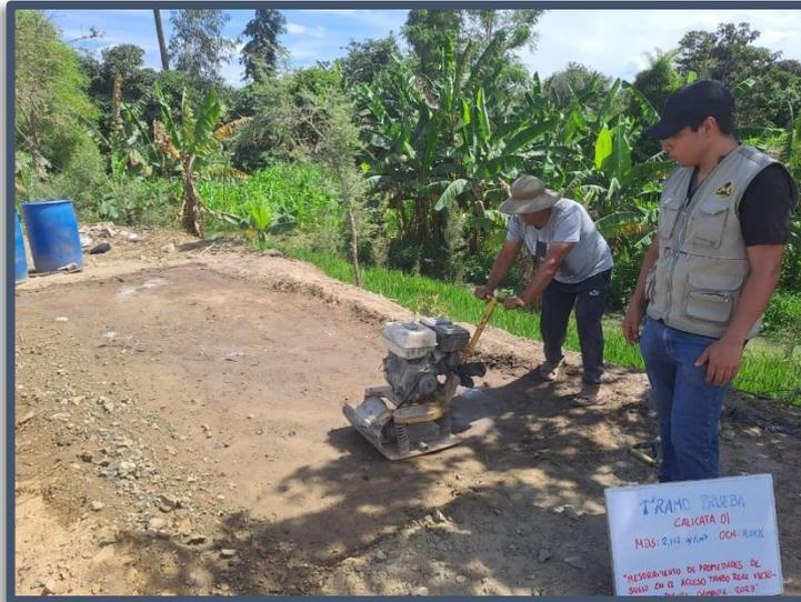
**Figura N°(26, 27 y 28):** Compactación de tramo de prueba 01, haciendo uso de plancha compactadora, de manera longitudinal y con las repeticiones necesarias.
