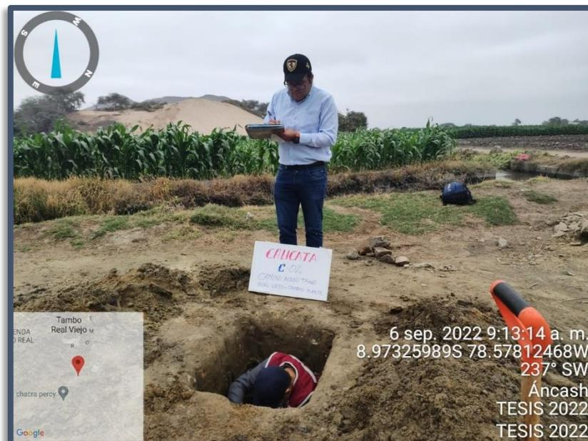
**Figura N°02:** Muestreo de suelos mediante calicata C-02, en la via Tambo Real Viejo – Cambio Puente. MTC E 101
