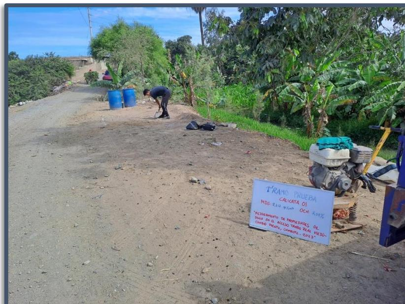
**Figura N°13 y 14:** Ubicación y delimitación de los 02 Tramos de Prueba de magnitudes 6.00 m. x 3.00 m. y 0.15 m. de profundidad.
