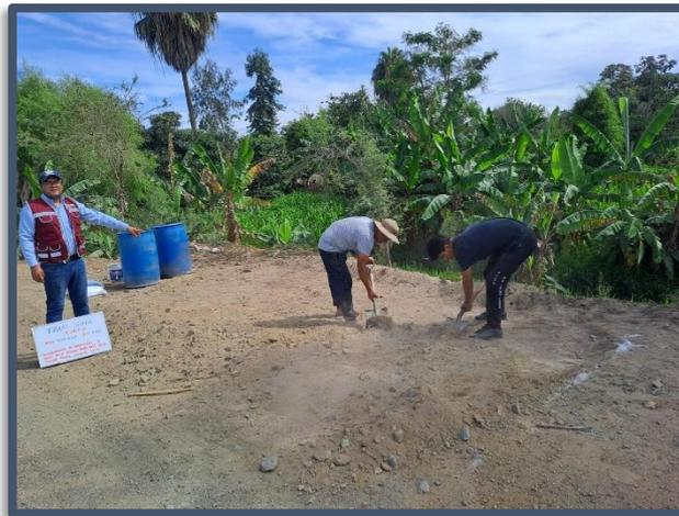
**Figura N° 15, 16, 17 y 18:** Limpieza y escarificación de material propio en los Tramos de Prueba haciendo uso de palas y rastrillos, así como una cuadrilla de 02 peones.
