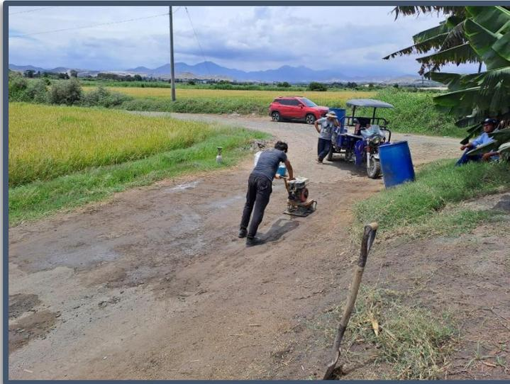
**Figura N°(29, 30 y 31):** Compactación de tramo de prueba 02, luego de alcanzar la máxima humedad óptima con el 5% de NaCl en función al peso seco del tramo.
