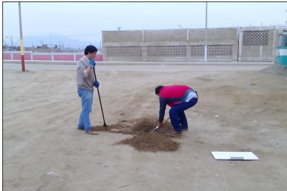
Fotografía 04. Excavación de la calicata C-2 para extraer el suelo a ensayar con ayuda de personal Técnico de laboratorio de la EPIC de la UNS (Latitud -9.050854; Longitud -78.587786)
