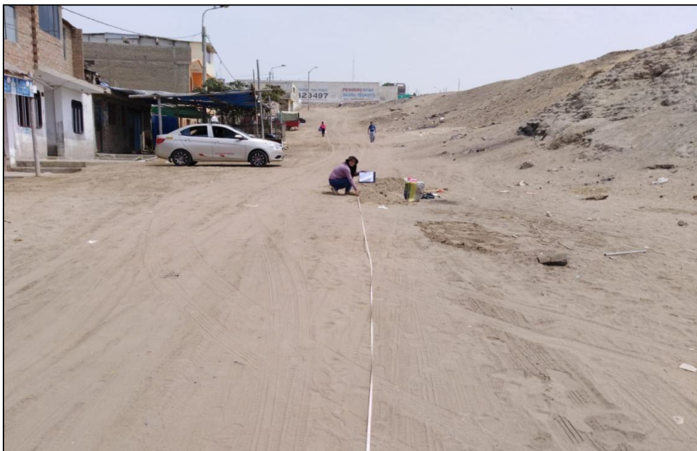
Fotografía 02. Delimitando el área para realizar la extracción de muestras mediante calicatas calle s/n (Latitud -9.050218; Longitud -78.587507)
