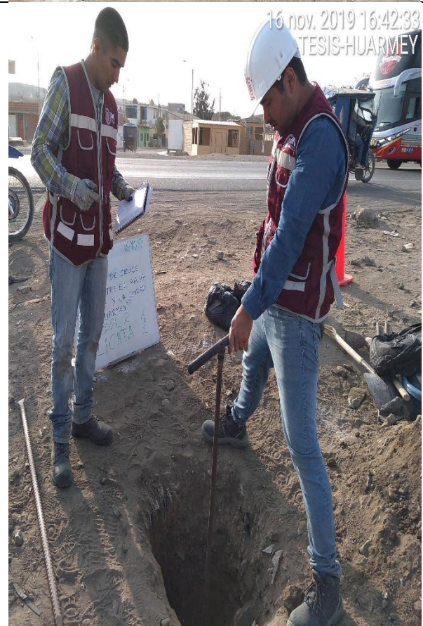
Fotografía N° 05, 06, 07 y 08 : Excavación de Calicatas de acuerdo a la profundidad de estratos adquiridos en ambos lados de la Carretera Panamericana.
