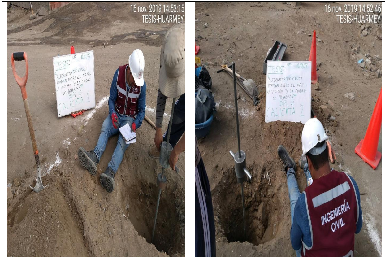
Fotografía N° 17 y 18 : Recolección de datos como profundidad de estratos y clasificación de muestras en ambas calicatas.
