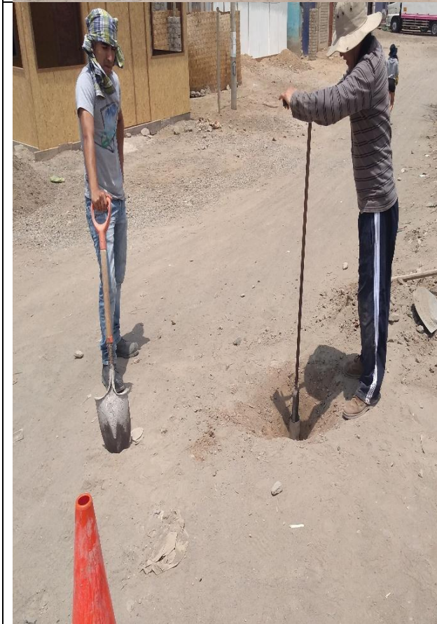
Fotografía N° 05, 06, 07 y 08 : Excavación de Calicatas de acuerdo a la profundidad de estratos adquiridos en ambos lados de la Carretera Panamericana.
