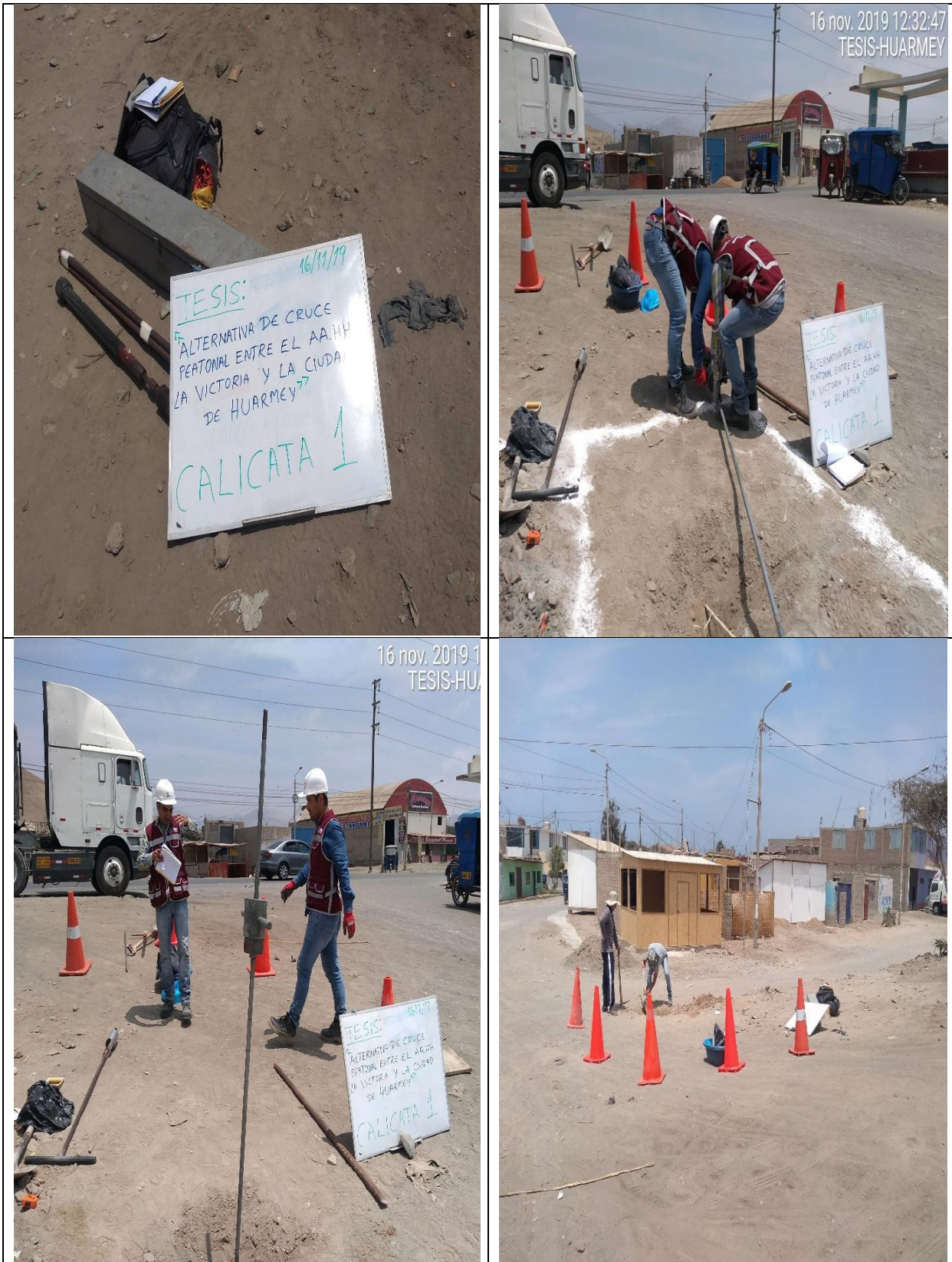
Fotografía N° 01, 02, 03 y 04 : Ubicación, trazo y cercado con conos de seguridad para el área de excavación de Calicatas en ambos lados de la Carretera Panamericana.
