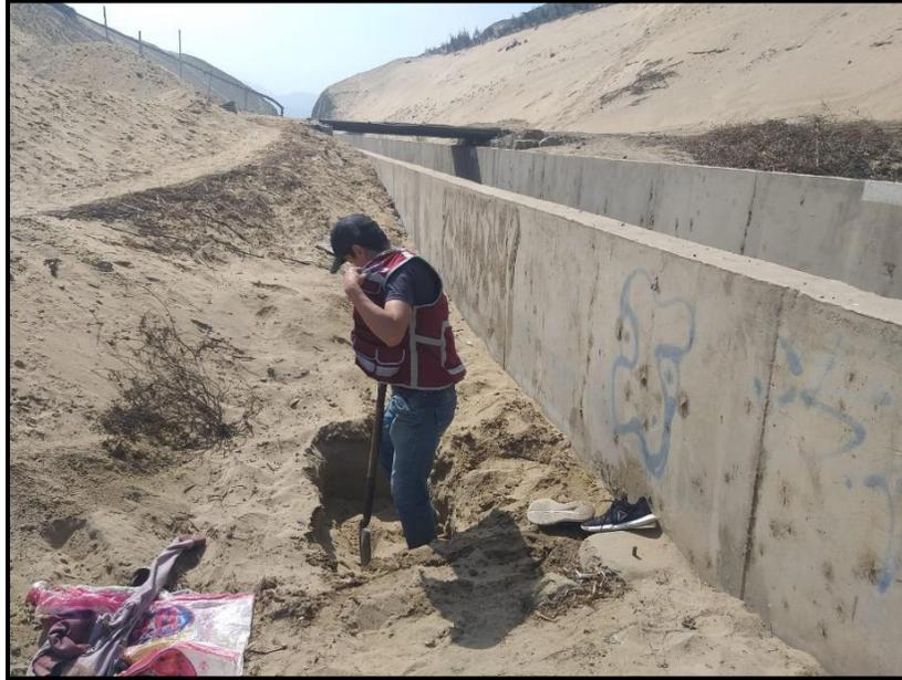
**FIGURA N° 54** ESCAVANDO LA ZONA, HASTA ENCONTRAR DIFERENTES ESTRATOS
