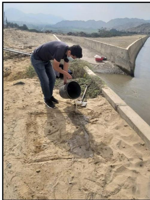
**FIGURA N° 53** HUMEDECIENDO LA ZONA DE ESCAVACIÓN
