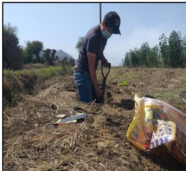
**FIGURA N° 59 CULMINACIÓN DE ESCAVACIÓN DE LA CALICATA N° 02 SE ENCONTRARON 2 TIPOS DE ESTRATOS.**
