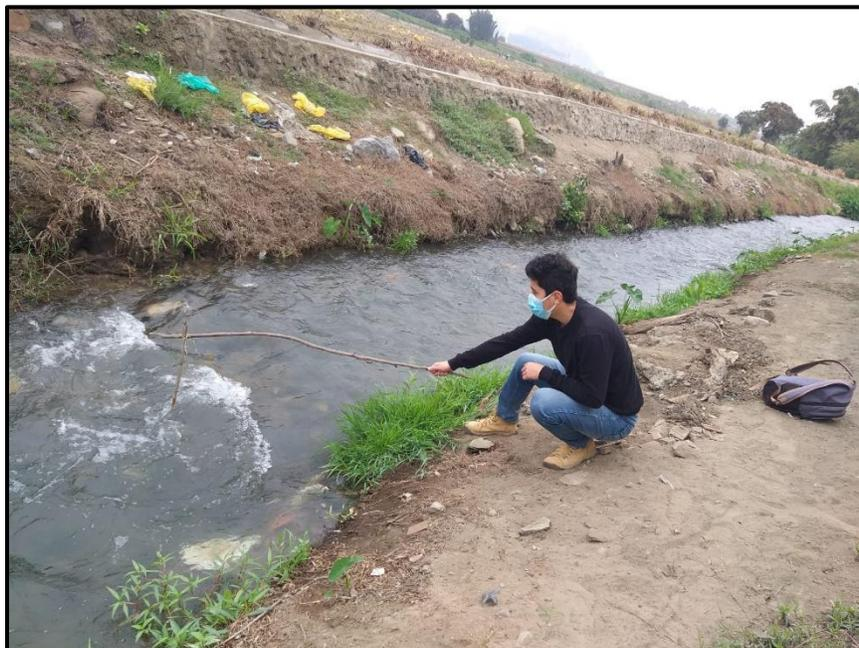
**Figura N° 21** Medición de las secciones del dren
