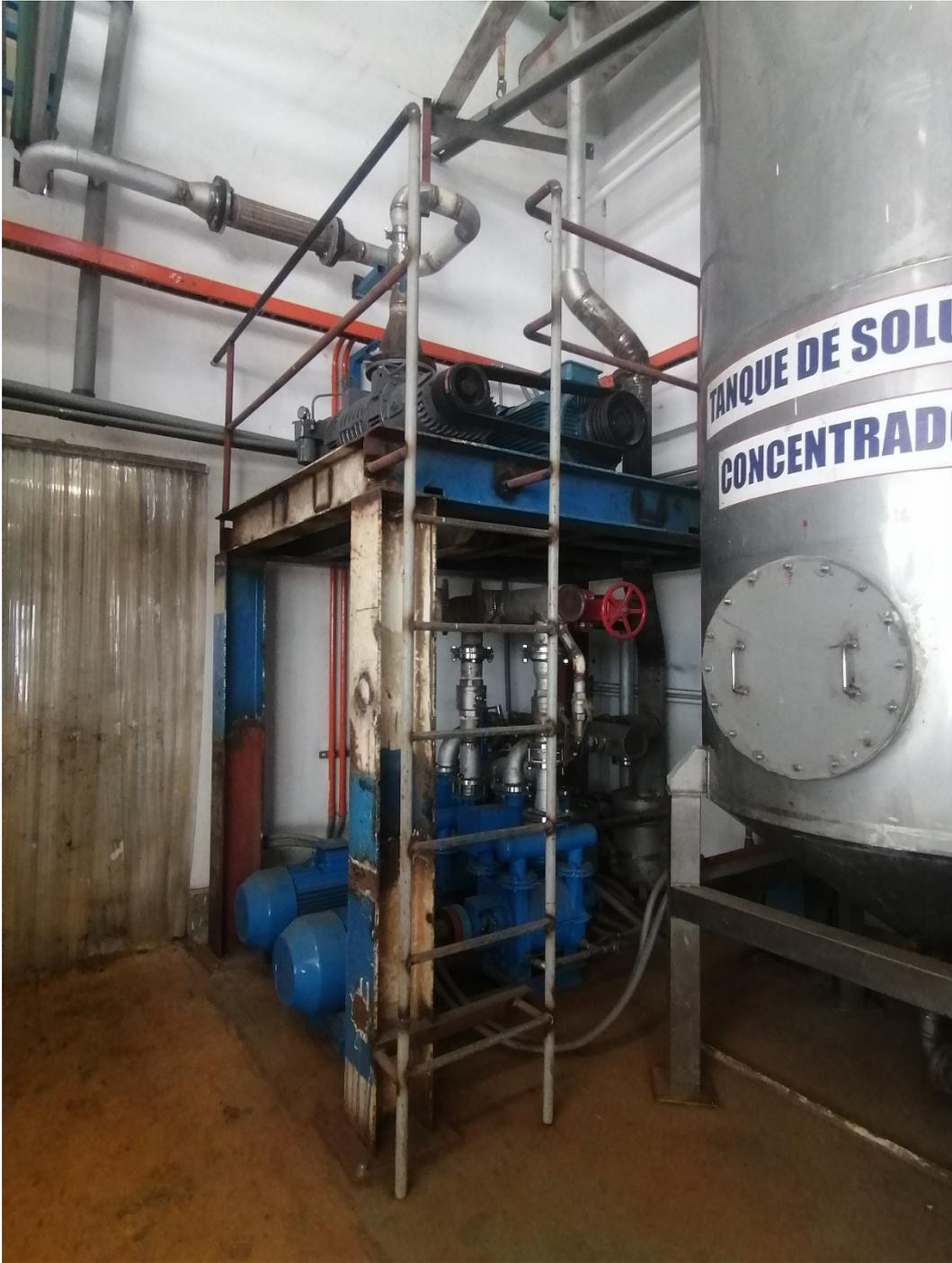
Bombas de vacío para secador Rotadisco (Secado final)
