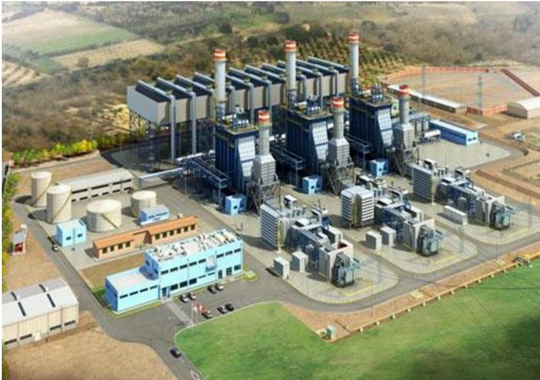
Figura 10 Esquema de equipos de central de ciclo combinado de Kallpa 3x3x1
