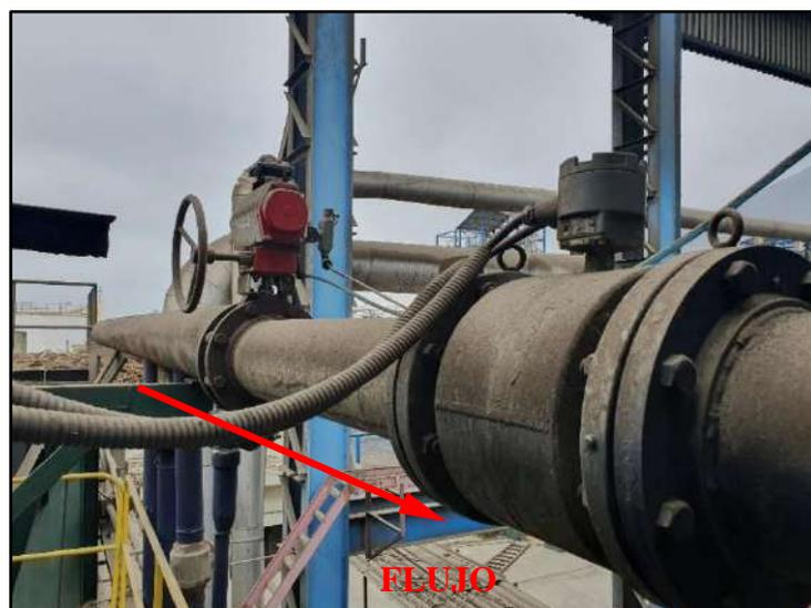
**Figura 9. Flujómetro de PLC**
