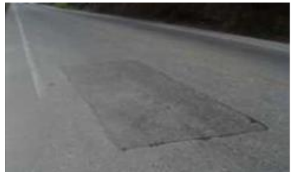
Figura 9. Parche deteriorado.
