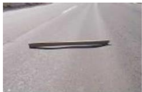
Figura 11. Ahuellamiento.
