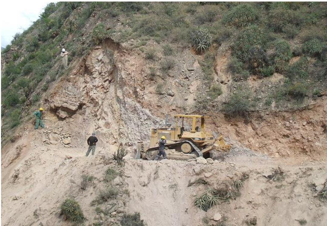
Vista de la excavación masiva, donde no se cuenta con explosivos por falta de abastecimiento de materiales y el rendimiento de corte en roca fija es por debajo del expediente, se estima que habrá mayores metrados en corte de roca fija.
