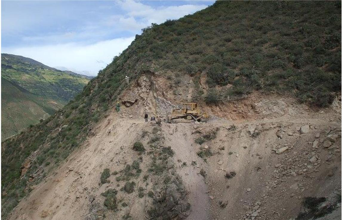
Excavación masiva con el tractor oruga, es el tramo de roca dura, que es de 50m y se necesita explosivos para realizar el corte.
