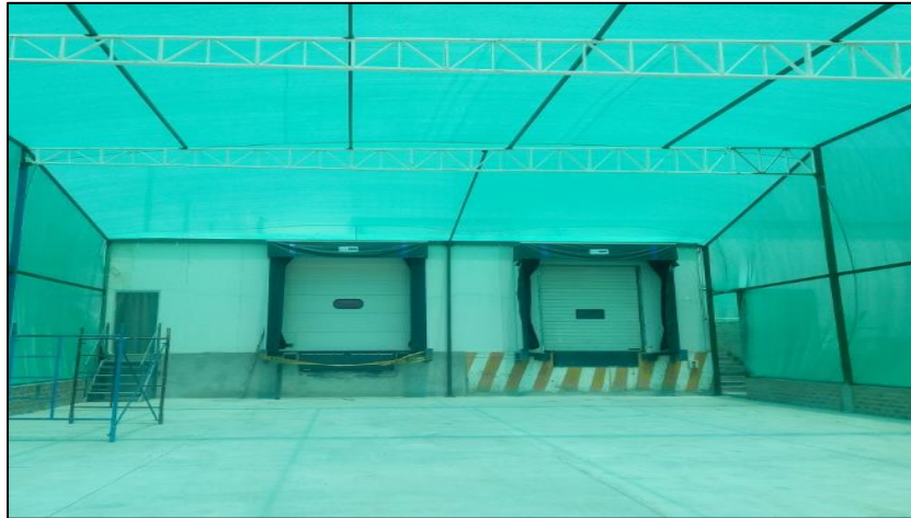
Figura 46: Zona de Despacho Con Resguardo Fitosanitario
