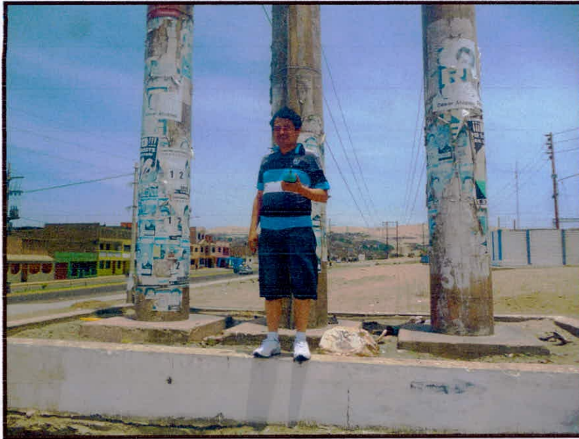
Foto N° 07: Toma de datos en la estructura de la L.T.
