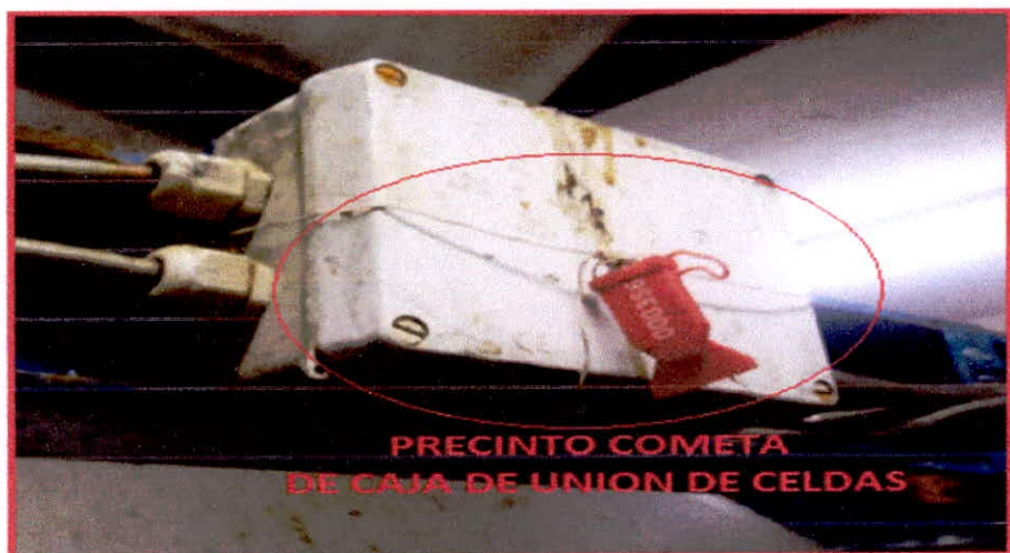
Figura 23. Precinto cometa de la caja de unión de celdas
