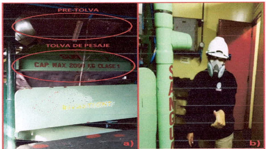
Figura 26. Verificación que el recurso sea transportado hacia la tolva de pesaje
