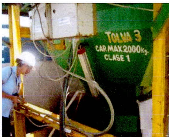
Figura 20: verificando la compuerta de la Tolva.
