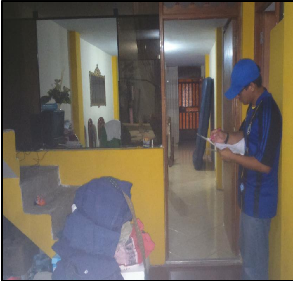
Fotografía 07. Urb. Unicreteo Mz T 3 It 47, Se observa apertura de ventana hacia la sala para brindar mayor iluminación natural.
