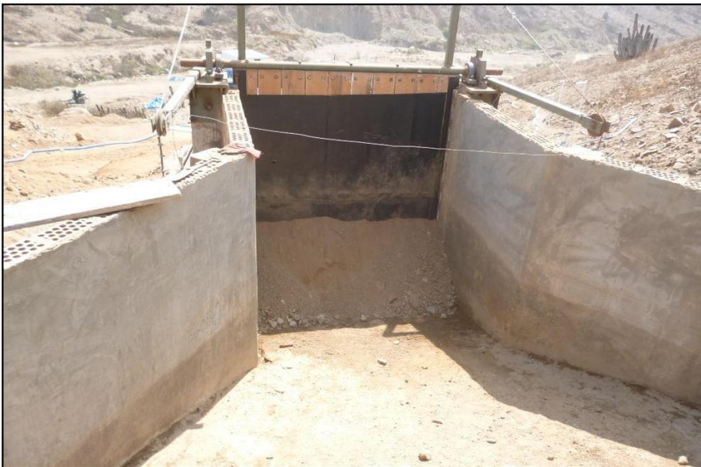
FOTO 06: Conformado del dique (material sólido) dentro del reservorio.
