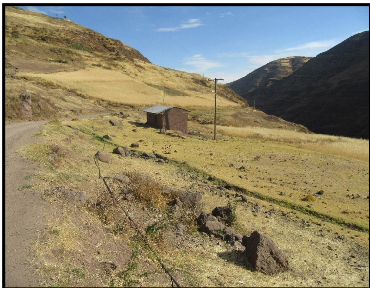
FOTO 03: Tuberías de agua potable de las Chacras de los usuarios.
