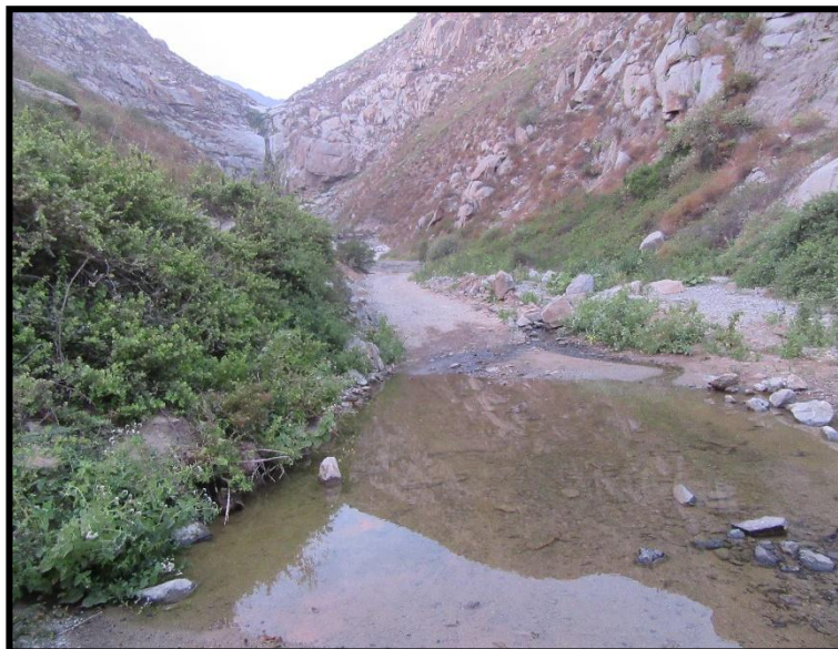
FOTO 02: Filtraciones de agua que afectan las chacras de los usuarios.
