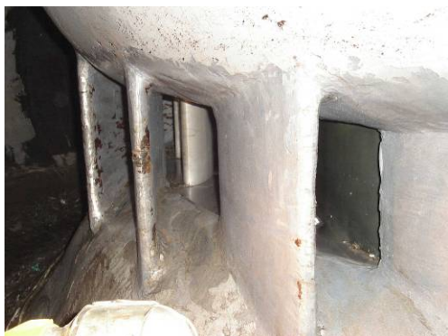
Fotos 4.5 y 4.6 Evaluación del estado del predistribuidor y caracol luego de la metalización efectuada y operación anual de las turbinas N° 1 (izq.) y N° 2 (der.)
