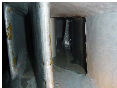
Fotos 4.5 y 4.6 Evaluación del estado del predistribuidor y caracol luego de la metalización efectuada y operación anual de las turbinas N° 1 (izq.) y N° 2 (der.)
