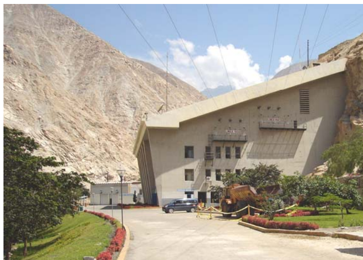
Foto N° 3.1. Vista panorámica de la Central Hidroeléctrica Cahua
