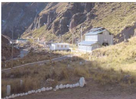
Figura 1.5. Central Hidroeléctrica Arcata
