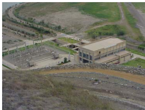
Figura 1.3. Central Hidroeléctrica Gallito Ciego
