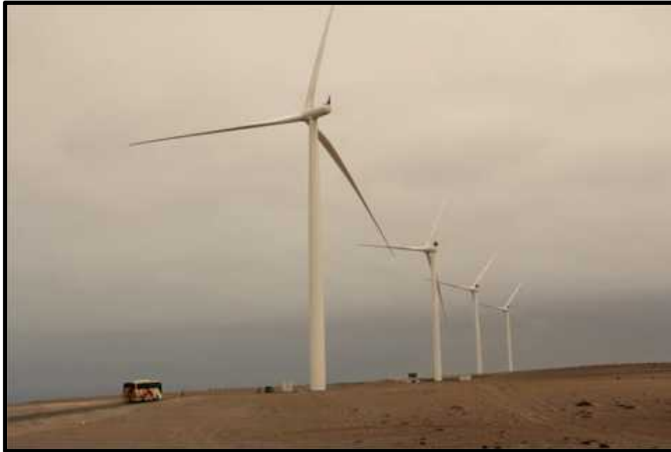
Figura 19. Parque Eólico en Marcona – Ica.
