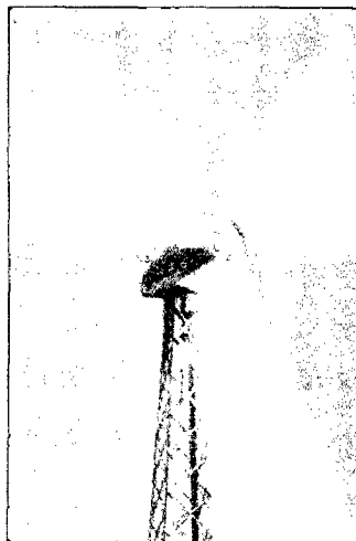
Torre de celosía
