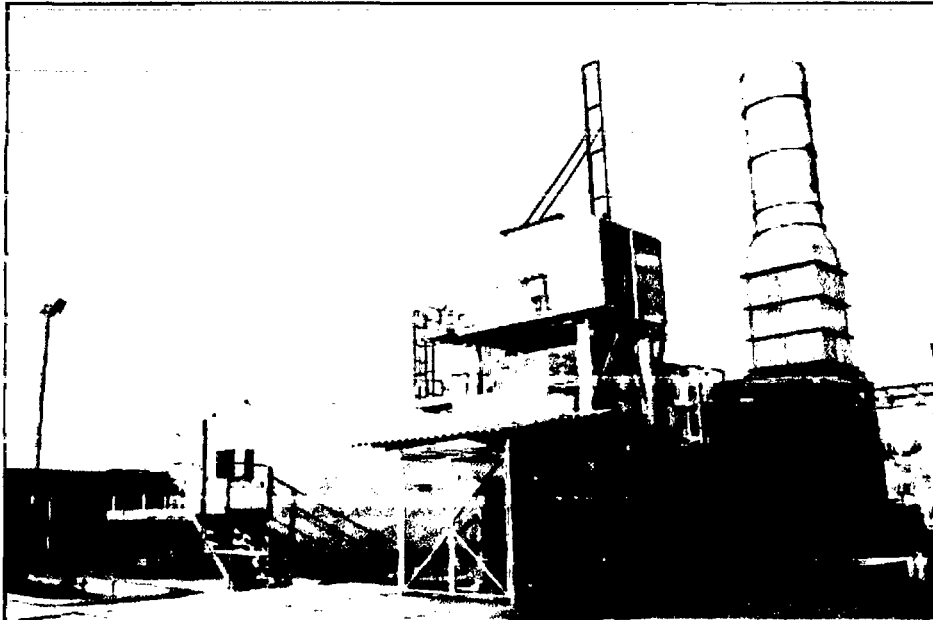
Figura N° 11 Central Termoelectrica El Tablazo (Colan-Piura)
