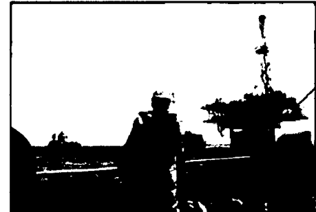
Vista panorámica de la Plataforma Corvina CX11 (Lugar donde se inicia el gaseoducto)
