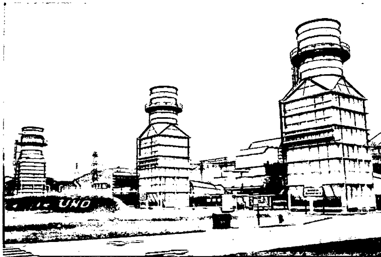
Figura N° 14 Central Termoelectrica Ciclo Combinado Chilca
